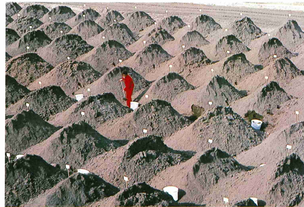
50 von insgesamt 16.000 Aushubchargen, die in Povel-Nordhorn analysiert worden sind
