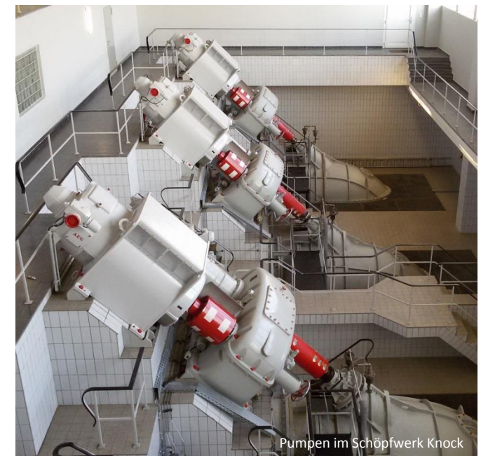
Siel- und Schöpfwerk Knock
