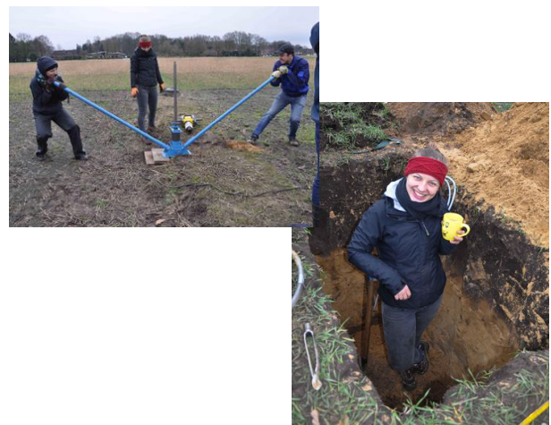
Projekt: Verhalten von Tierarzneimitteln in Boden und Grundwasser - Bau einer Grundwassermessstelle
